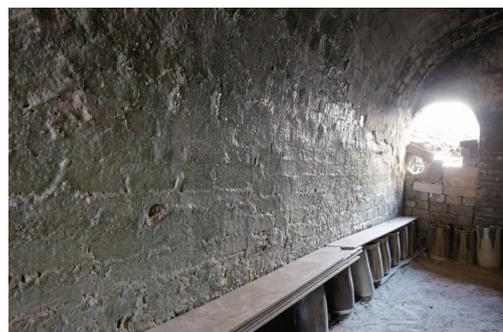
図4 登り窯内部。投げ込まれた薪による自然釉が壁面につく。
